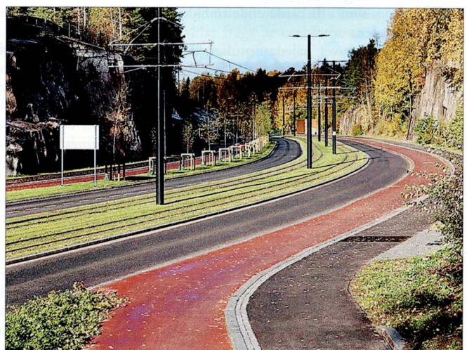
En cykelväg byggs parallellt med den nya spårvägen. FOTO: SPÅRJOKERN
