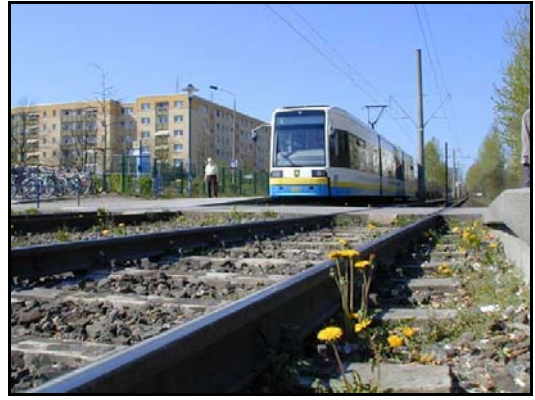
En egen lukket tracé kan anlægges både i vejmidten og i vejsiden som her i Schwerin i Nordtyskland. Egen lukket trace anlægges med almindelige jernbaneskiner i skærver, og behøver ikke at følge vejnettet.
