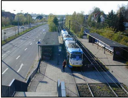
En egen lukket tracé kan anlægges både i vejmidten og i vejsiden som her i Schwerin i Nordtyskland. Egen lukket trace anlægges med almindelige jernbaneskiner i skærver, og behøver ikke at følge vejnettet.
