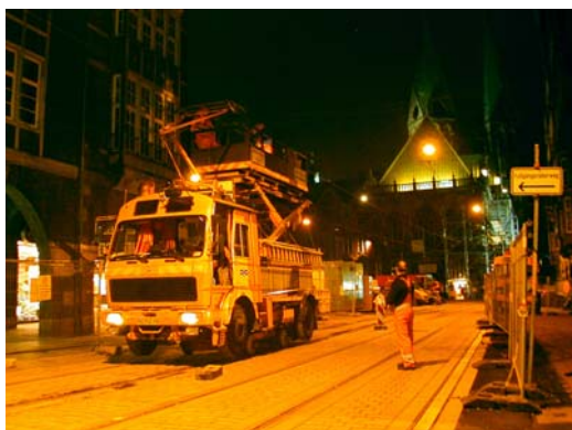
Justering af køreledninger efter en større renovering af gågaden i Bremen.
