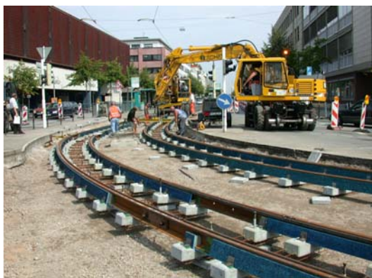
Anlæggelse af nye spor med gummipuder og isolering af vibrationer i nærheden af banegården i Mannheim.
